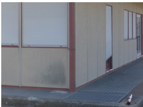
Figura 4.5 – Rilievo termografico dei serramenti modulari
