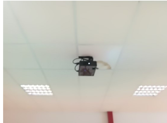
Figura 4.13 - Particolare dei corpi illuminanti ubicati nell'aula magna
