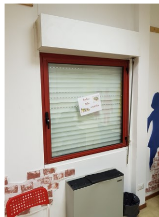
Figura 8.1 - Particolare dei serramenti esistenti
